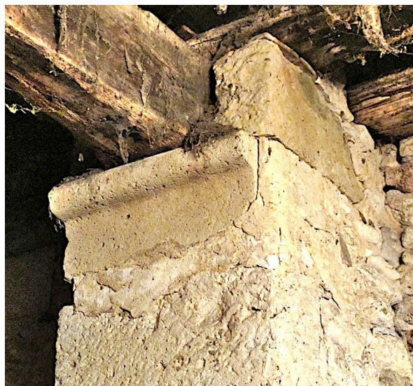
Fig. F 09 - Bâtiment E, pilastre avec réemploi de coussièges (Photo : Michel Piechaczyk, ADM).
