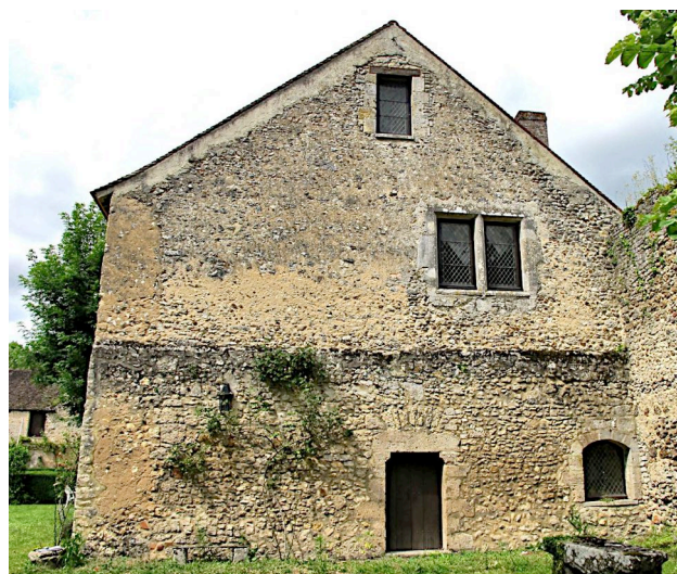
Fig. F 07 - Pignon sud du bâtiment B (Photo : Michel Piechaczyk, ADM)
