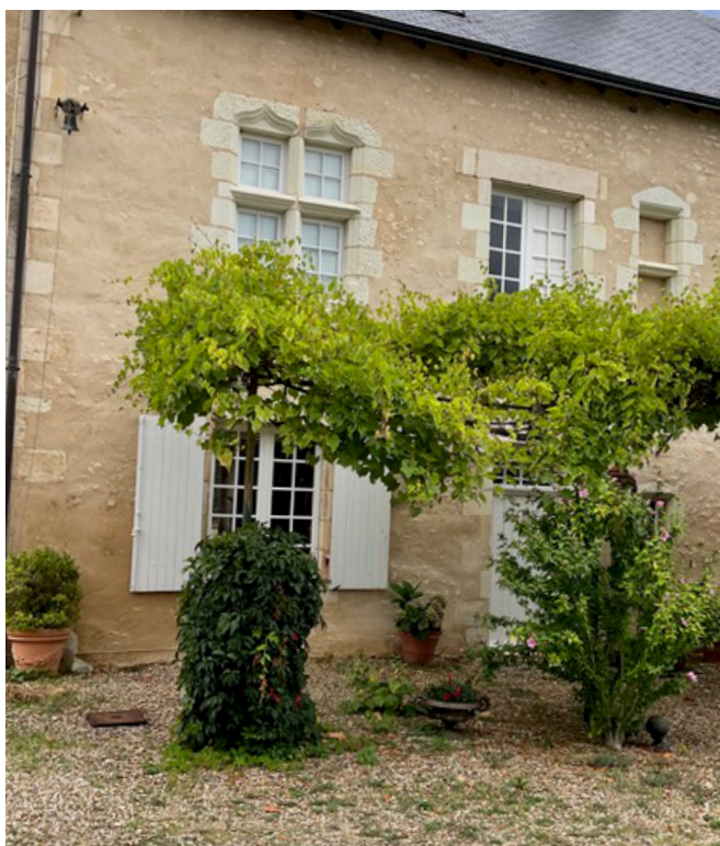
Fig. E 16b - Une élégante fenêtre à meneaux et croisillons au dessus de la vigne (Photo : Hélène et François Harismendy/ADM).
