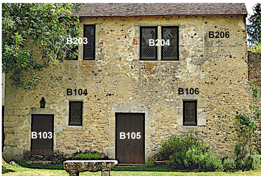
Fig. F 06 - Façade ouest du bâtiment B (Photo : Michel Piechaczyk, ADM)
