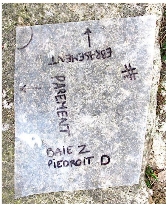
**Fig. L 20** - Panneau en plastique faisant office de gabarit après découpe et relevé de l'angle
