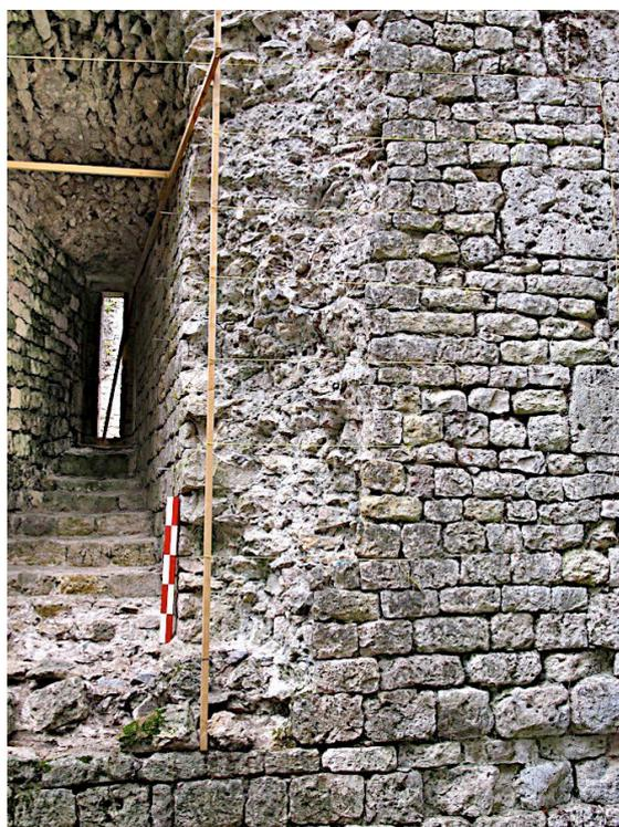
**Fig. L 23** - Matérialisation des arêtes du piédroit droit de la Z1.02 par des tasseaux, et de ses assises par des cordelettes jaunes / mire = 0,50 m
