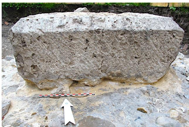
**Fig. G 11** - Traces de bretteuse sur le socle ST195
