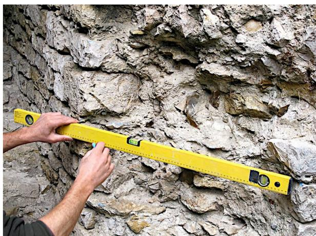
**Fig. L 22** - Vérification au niveau d'une assise arrachée du piédroit droit de la baie Z1.03
