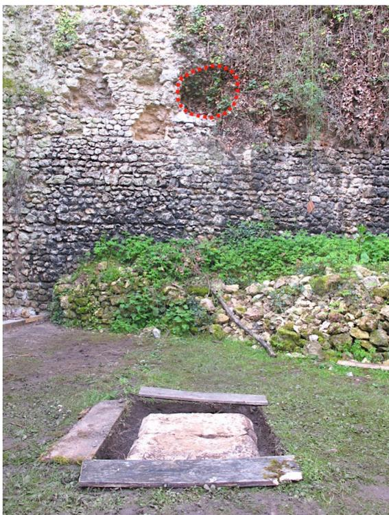
**Fig. G 37** - Négatif d'un empotement de poutre visible dans le parement interne de la courtine C3, aligné avec le socle ST198 (Photo : Florian Hemery, ADM).
