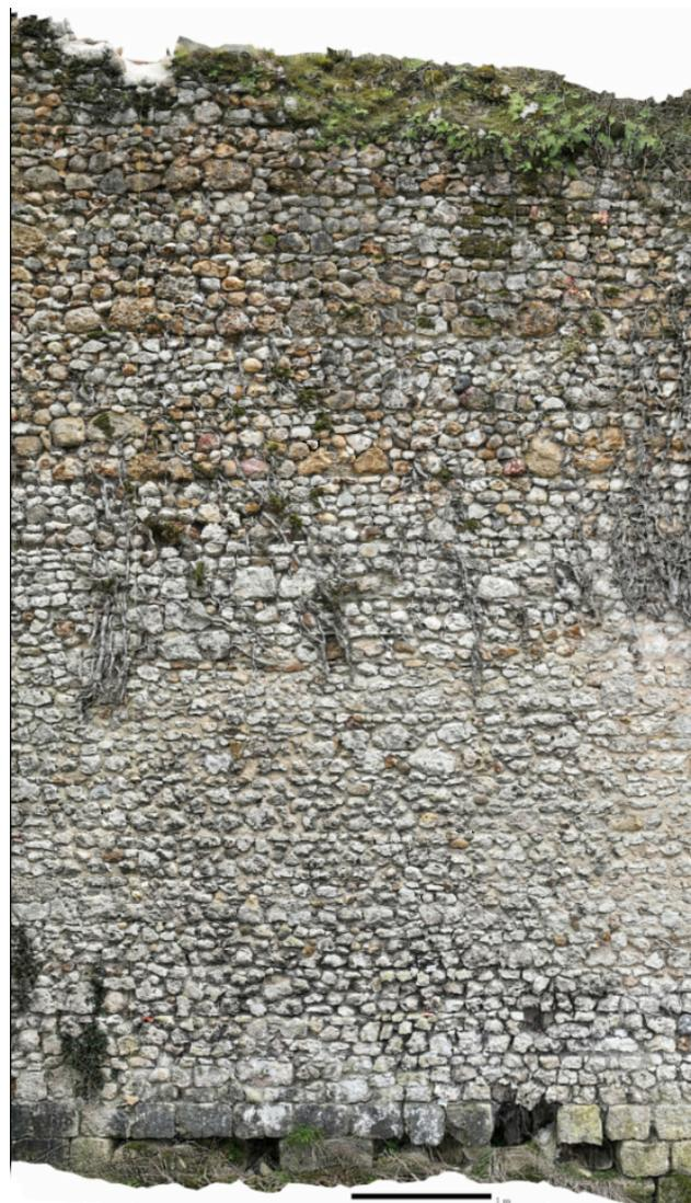
**Fig. M 19** - Photogrammétrie du parement de la courtine extérieure C4 sur la zone C4eZ4
