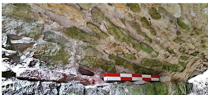
**Fig. L 37** - Voûtement de la baie Z1.04 avec négatifs de couchis. On remarque également la présence de terres cuites architecturales matérialisant le départ de la voûte
