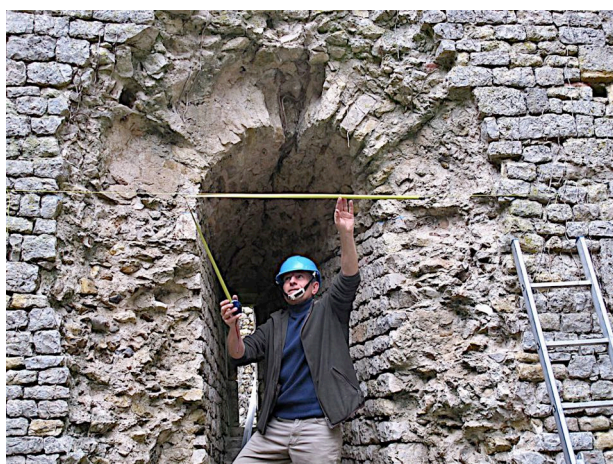
Fig. L 18 - Mesure de l'ouverture de la baie Z1.03 (Photo : Florian Hemery, ADM).
