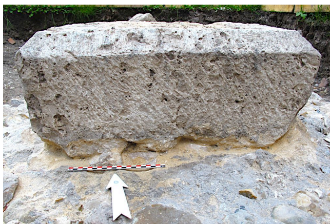
Fig. G 11 - Traces de brettage sur le socle ST195 (Photo : Edwige Borel, ADM).
