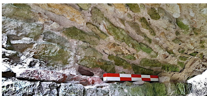
Fig. L 37 - Voûtement de la baie Z1.04 avec négatifs de couchis. On remarque également la présence de terres cuites architecturales matérialisant le départ de la voûte (Photo : Florian Renucci, ADM).
