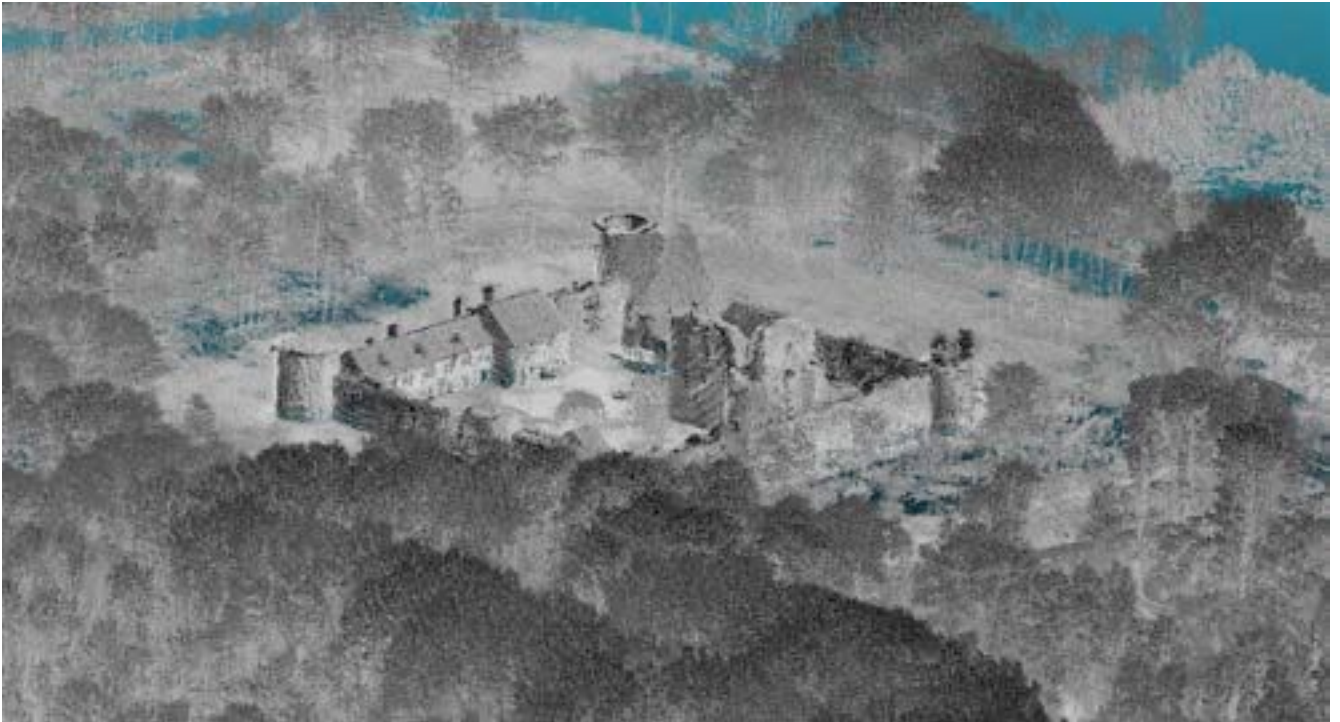
Fig.5 Nuage de points géoréférencé : vue oblique du château de Mez-le-Maréchal
