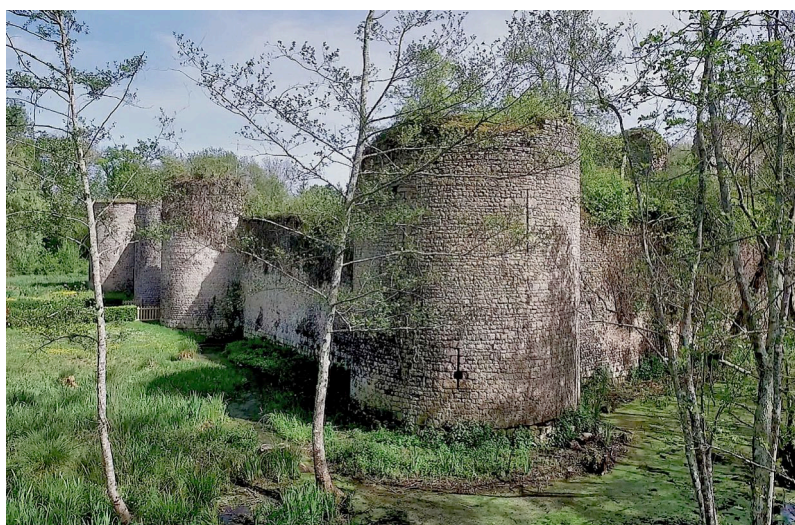
Fig. J 01 - La tour nord-ouest (T4) vue du nord-ouest (Photo : ADM).
