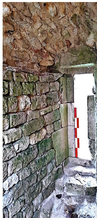
Fig. L 39 - Voûtement de la baie Z1.05. On remarque la présence de terres cuites architecturales dans la voûte ainsi que sur le sommet de la retraite (Photo : Florian Renucci, ADM).
