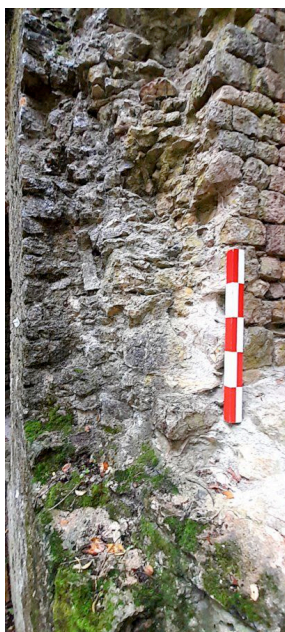
Fig. L 02 - Arrachements visibles des pierres de taille du piédroit gauche de la baie Z1.06 (Photo : Florian Renucci, ADM).
