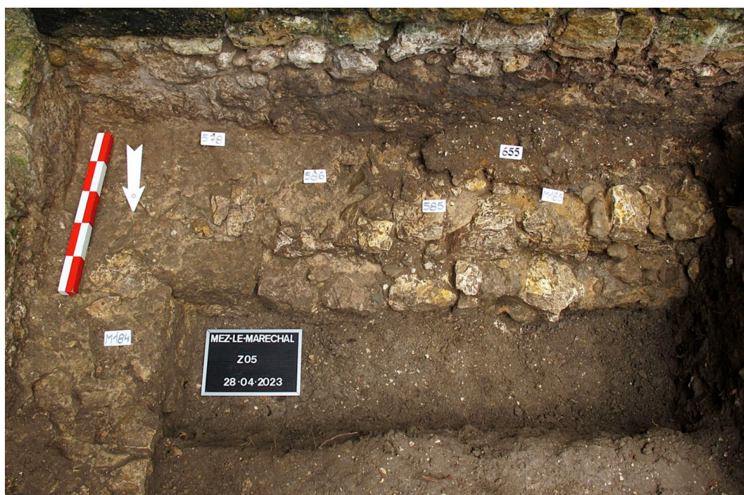
Fig. G 08 - Semelle de fondation M185 de la courtine C3, dans l'angle de la tour T2, au niveau du chaînage avec M188 (= M184) (Photo : Edwige Borel, ADM).
