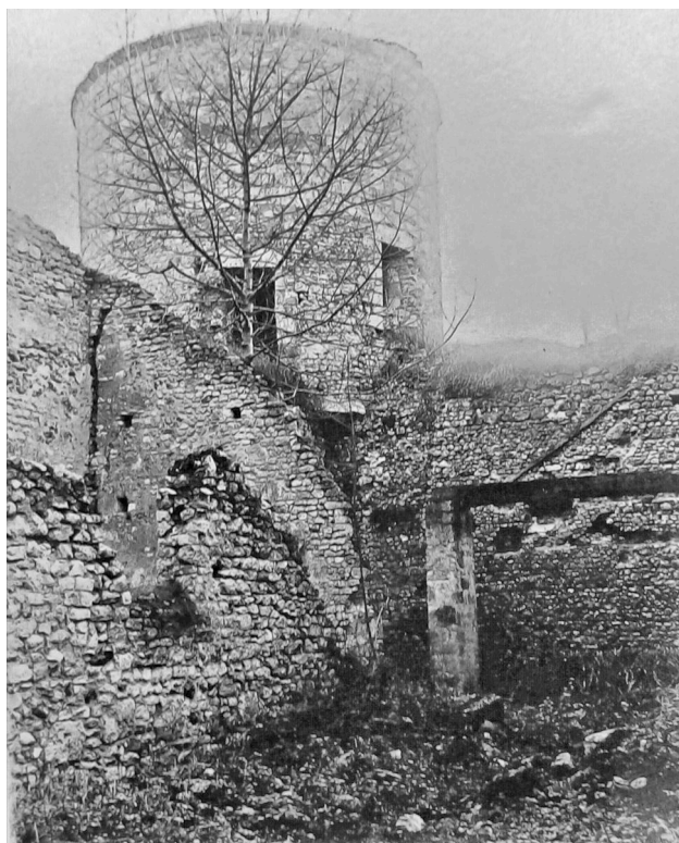
Fig. G 04 - Vestiges d'un bâtiment avec toit en appentis, adossé contre la courtine C2, 1884 (BNF, Cabinet des estampes, EN1-41).
