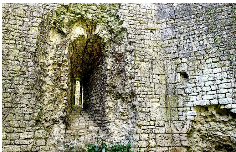
Fig. K 07 - Intérieur du niveau 1 de la tour résidence. Aspect du parement et des chaînages (Photo : ADM).
