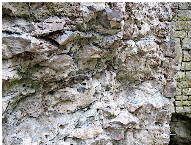
Fig. L 21 - Lits d'attente marqués à la craie bleue sur le piédroit droit de la baie Z1.03 (Photo : Florian Hemery, ADM).
