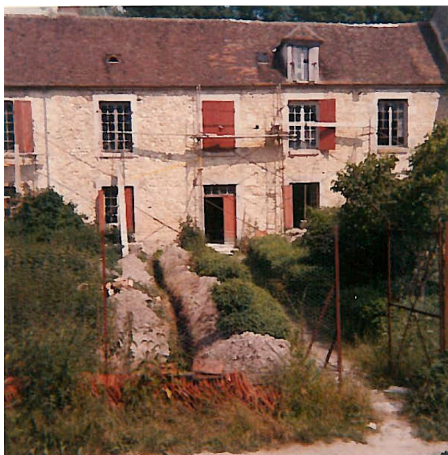
Fig. H 03 - Tranchée effectuée devant le bâtiment A, en 1964 (Archives privées Vincent, AV-015).
