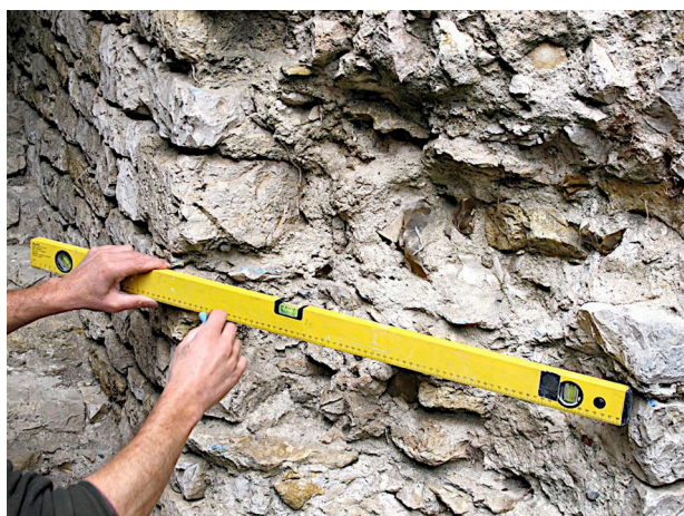
Fig. L 22 - Vérification au niveau d'une assise arrachée du piédroit droit de la baie Z1.03 (Photo : Florian Hemery / ADM).
