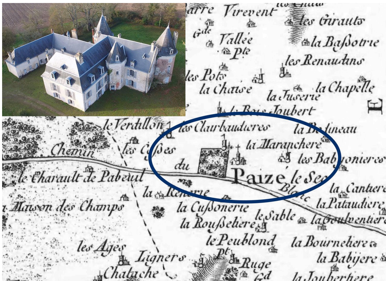
Fig. E 14b - Photo aérienne du château des Clerbaudières, près de Paizay-le-Sec en 2023. Le château est actuellement en grands travaux, tout bardé d'échafaudages.
