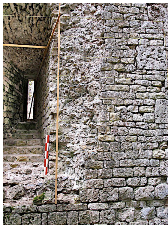
Fig. L 23 - Matérialisation des arêtes du piédroit droit de la Z1.02 par des tasseaux, et de ses assises par des cordelettes jaunes / mire = 0,50 m (Photo : Florian Hemery, ADM).
