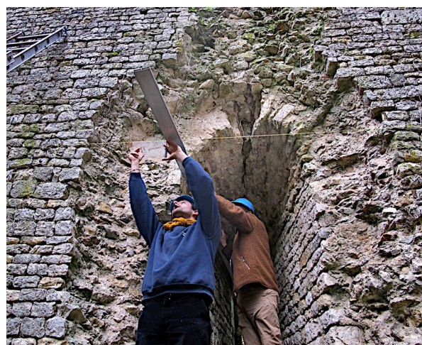
Fig. L 19 - Décalquage de l'angle de l'ébrasement et du parement de la baie Z1.03 avec un panneau plastique (Photo : Florian Renucci, ADM).
