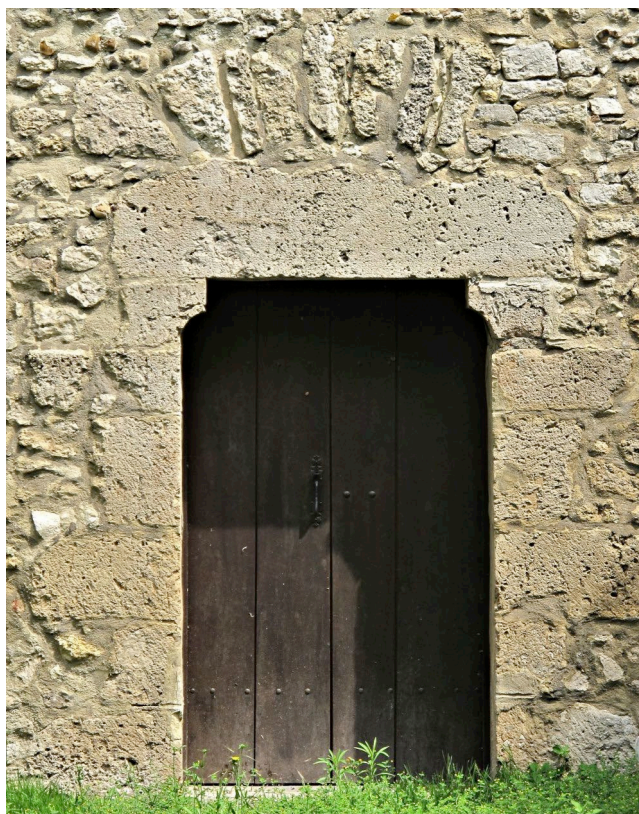
Fig. G 18 - Porte B107, vue depuis le bâtiment C (Photo : ADM).
