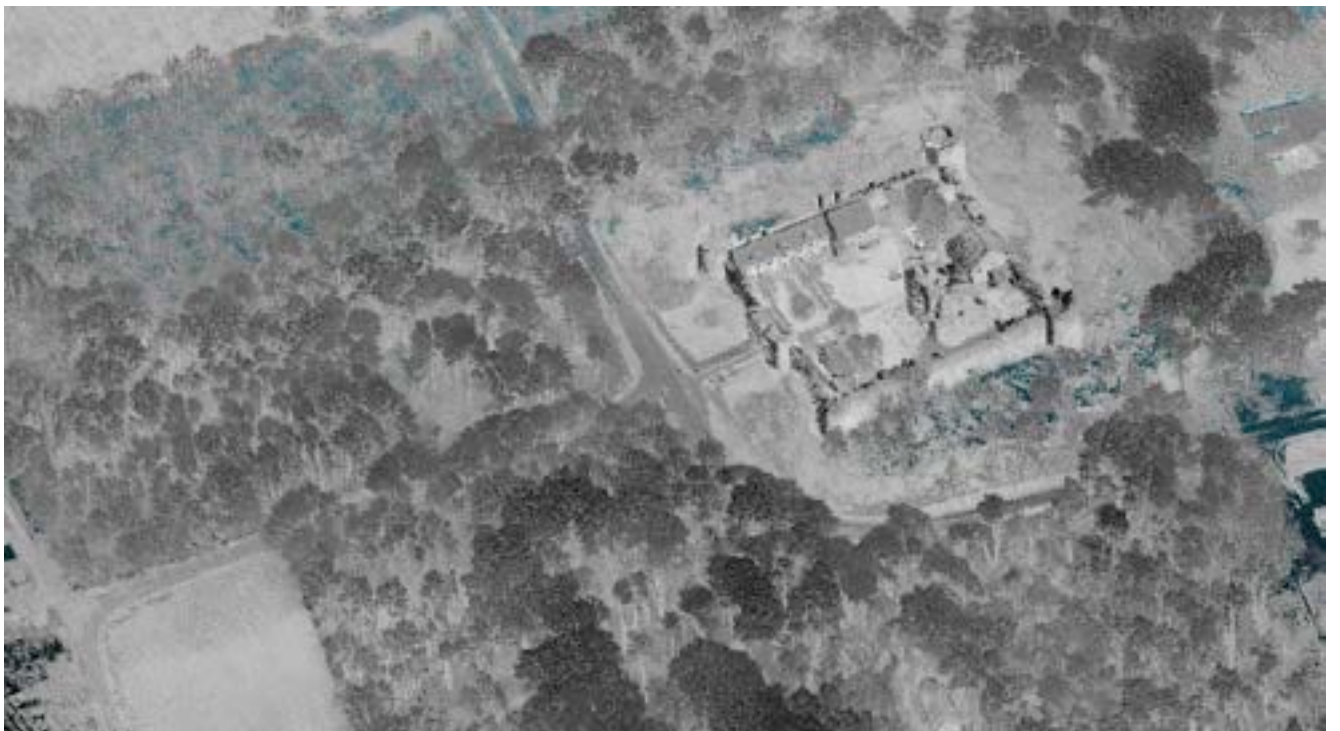
Fig.6 Nuage de points géoréférencé : vue oblique du château de Mez-le-Maréchal
