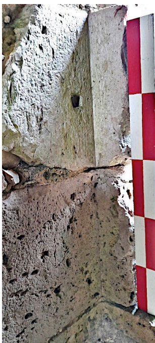
Fig. L 06 - Trou de loquet sur l'ébrasement gauche de la Z1.06 permettant de fermer le vantail / mire = 0,50 m (Photo : Florian Renucci, ADM).
