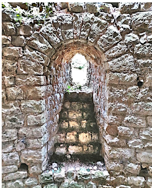
Fig. L 09 - Baie à ébrasement avec appui en escalier de la tour maîtresse de Saint-Vérain (58), XII e siècle (Photo : Florian Hemery, ADM).
