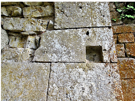
Fig. L 26 - Encoche en sommier d'une des ouvertures en plein cintre de l'abbaye de la Cour-Dieu (45), XII e siècle (Photo : Florian Hemery, ADM).
