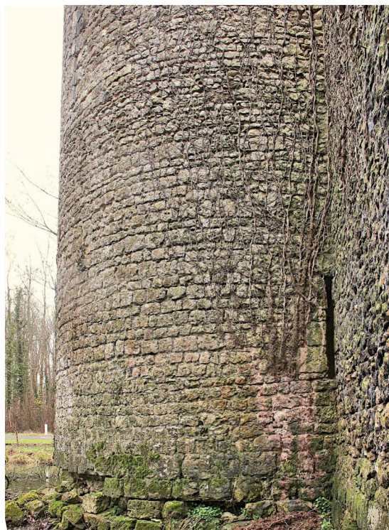
Archère T414 vers le sud
