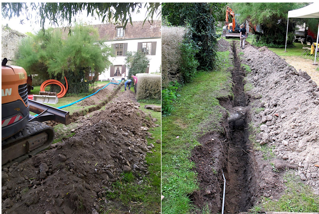
Fig. H 01 - Aperçu de la tranchée pour l'installation des nouvelles canalisations. À gauche : vue vers l'est, en direction du bâtiment A ; à droite : vue vers l'ouest, en direction de la remise (Photo : ADM).
