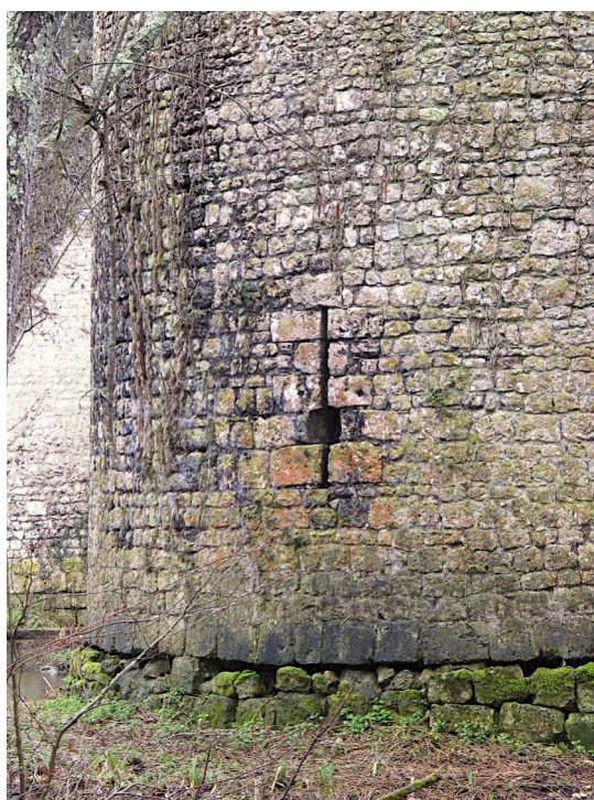
Archère bouche à feu T413 vers le nord-ouest
