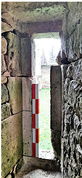
Fig. L 38 - Gonds et trou de loquet de la baie Z1.05 (Photo : Florian Renucci, ADM).
