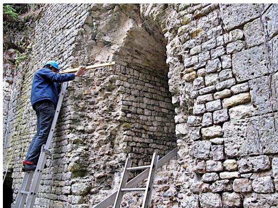
Fig. L 16 - Observation avec un niveau à bulle de la correspondance des joints horizontaux du parement et de l'ébrasement de la baie Z1.03 (Photo : Florian Renucci, ADM).
