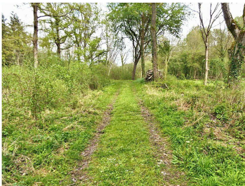
Fig. B 11 - Chemin sur la contrescarpe à l'est. Les espaces, jadis dégagés, sont envahis d'arbres et de taillis (Photo : Michel Piechaczyk / ADM).
