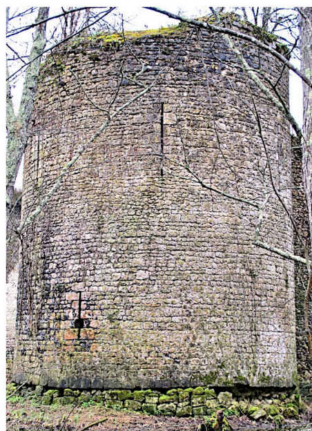
Tour T4 vue du nord-ouest
