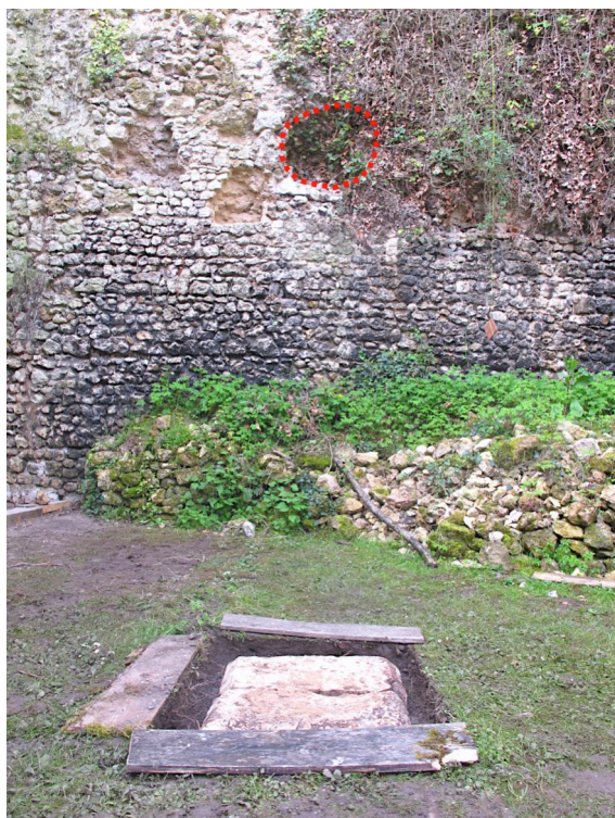
Fig. G 37 - Négatif d'un empochement de poutre visible dans le parement interne de la courtine C3, aligné avec le socle ST198 (Photo : Florian Hemery, ADM).
