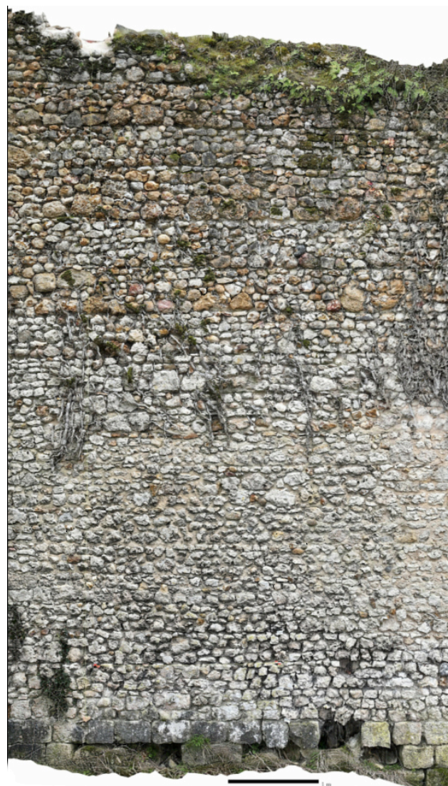
Fig. M 19 - Photogrammétrie du parement de la courtine extérieure C4 sur la zone C4eZ4 (Relevés : Corentin Parsigneau, Martine Piechaczyk, ADM)
