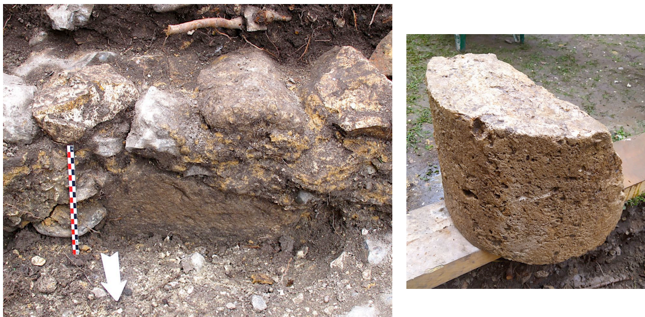
Fig. G 24 - Fragment de tambour de colonne n°614-001 en remploi dans le mur M189 (Photos : ADM).
