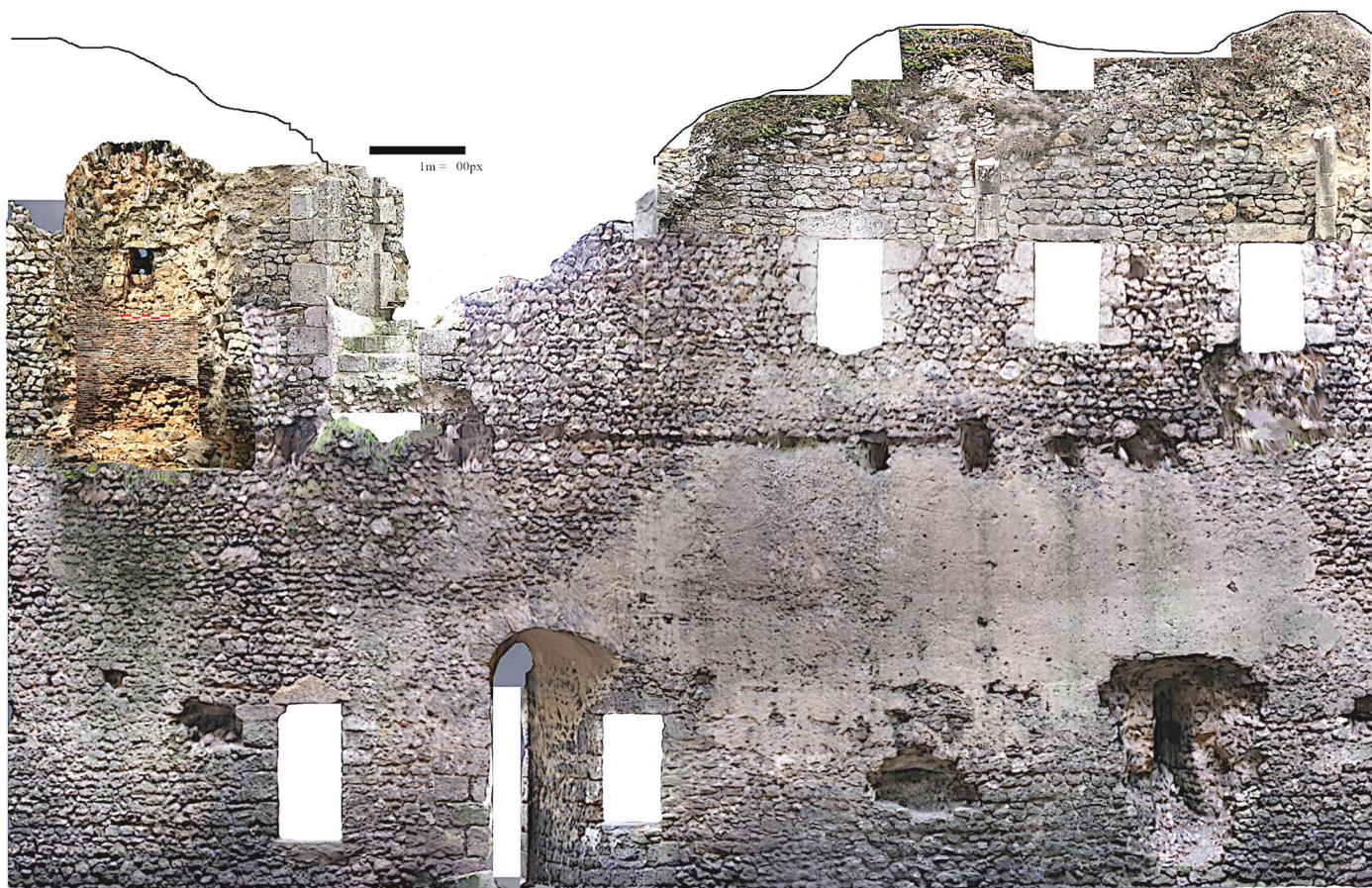
Fig. J 04 - Tour nord-ouest (T4) ; déroulé photogrammétrique du parement intérieur (Photogrammétrie : Philippe Lefeuvre, ADM).
