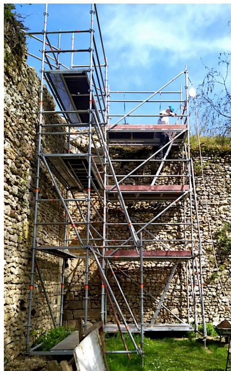
**Fig. F 02** - Tour d'échafaudages mise en place pour le dégagement de la courtine
