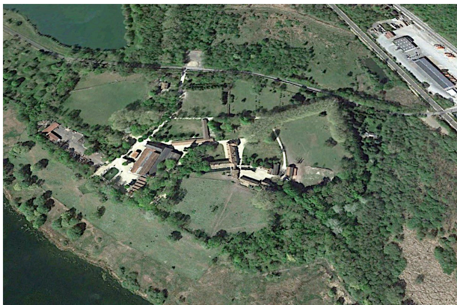
Fig. D05 - Le site de l'abbaye de Cercanceaux.
