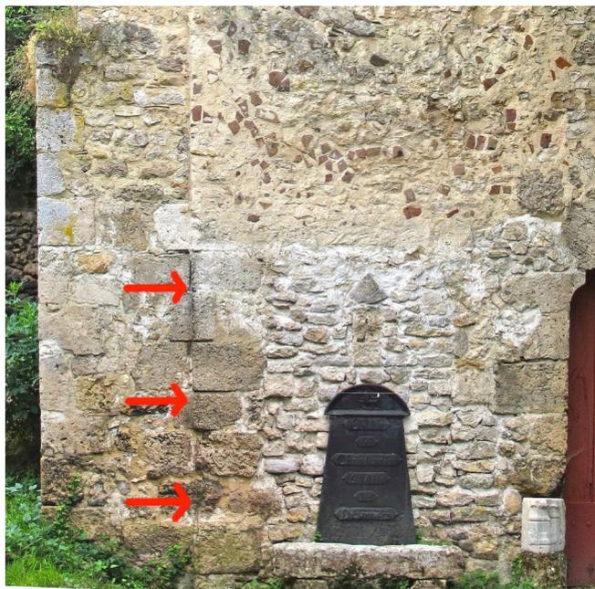
**Fig. E 05** - Vestiges d'une feuillure verticale, visibles sur le mur de façade du bâtiment D (Photo et DAO : Michel Piechaczyk, Edwige Borel, ADM).
