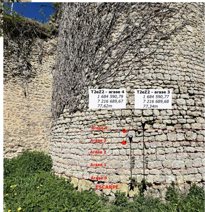
**Fig. H10** - Mesures de la zone d'étude altimétrique T2eZ1 jusqu'au sommet de l'escarpe (DAO : Virginie Bemer / ADM)
