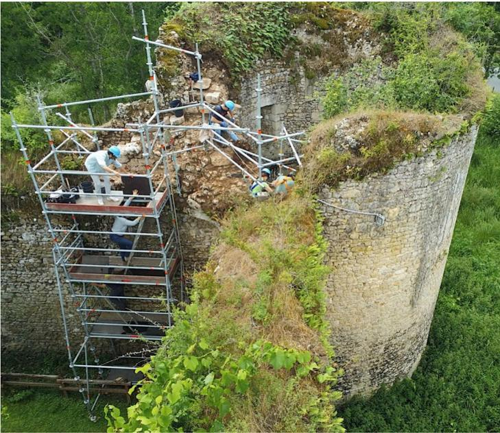
**Fig. G 02** : Module d'échafaudage mis en œuvre pour la fouille du sommet de la courtine C4 et de la tour T4 (Photo : Amaury et Corentin Parsigneau / ADM).
