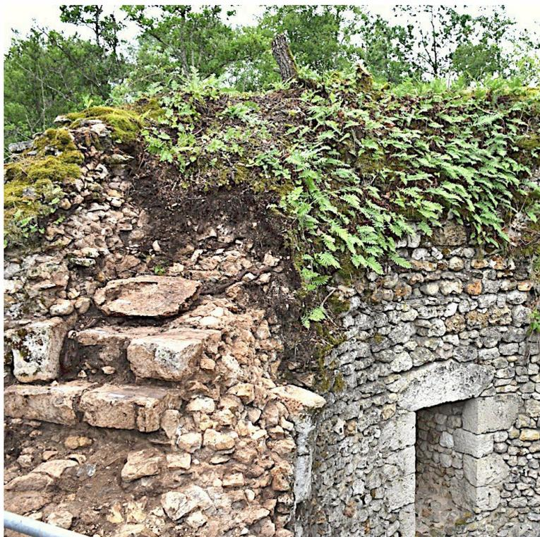
**Fig. G 17** : Tour T4. Rapport des maçonneries de la volée 4 des marches avec les archères de la salle haute (Photo : Florian Renucci / ADM).
