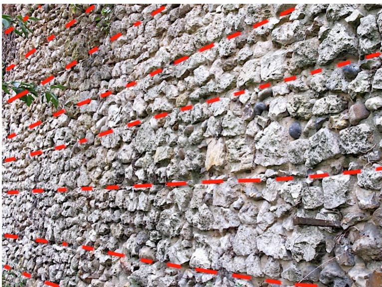
**Fig. N 01** : Visibilité des planées et des arases horizontales sur les élévations
