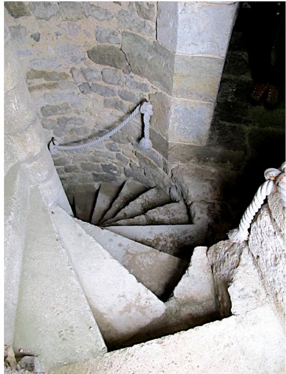
**Fig. L 08** - Yèvre-le-Châtel (Loiret). Exemple d'échappement sur vis continue (Photo : Michel Piechaczyk / ADM).
