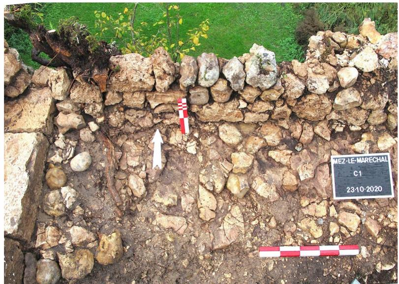
**Fig. L 14** - Chemin de ronde C1 à la surface dégradée. Vestiges du mur parapet M136 (Photo : Michel Piechaczyk/ ADM).
