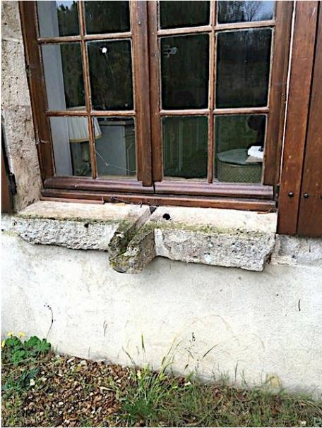
**Fig. H 30** - Le déversoir de la pierre à évier au niveau de l’appui de la fenêtre de la cuisine (Photo : Sylviane Delpech / ADM).
