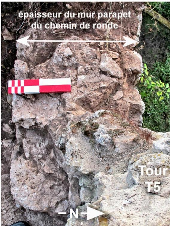
**Fig. F 22** - Chemin de ronde au dessus de la courtine C5 - Vestige de la base du mur parapet (Photo : Michel Piechaczyk / ADM).
