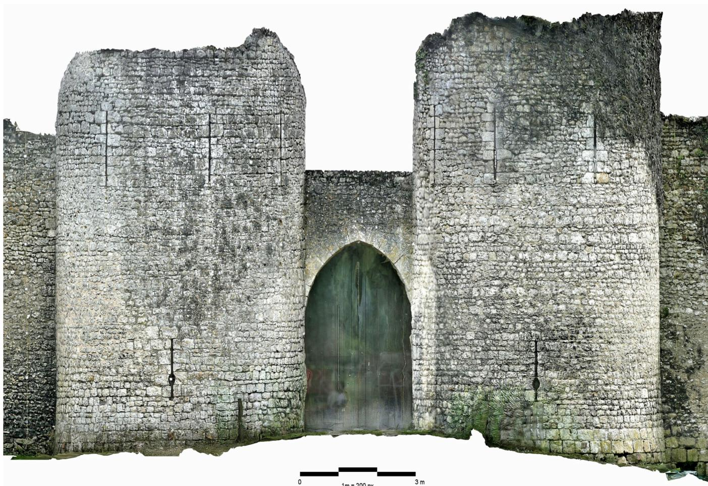
**Fig. F 04** - Orthophotographie frontale extraite du modèle photogrammétique.
