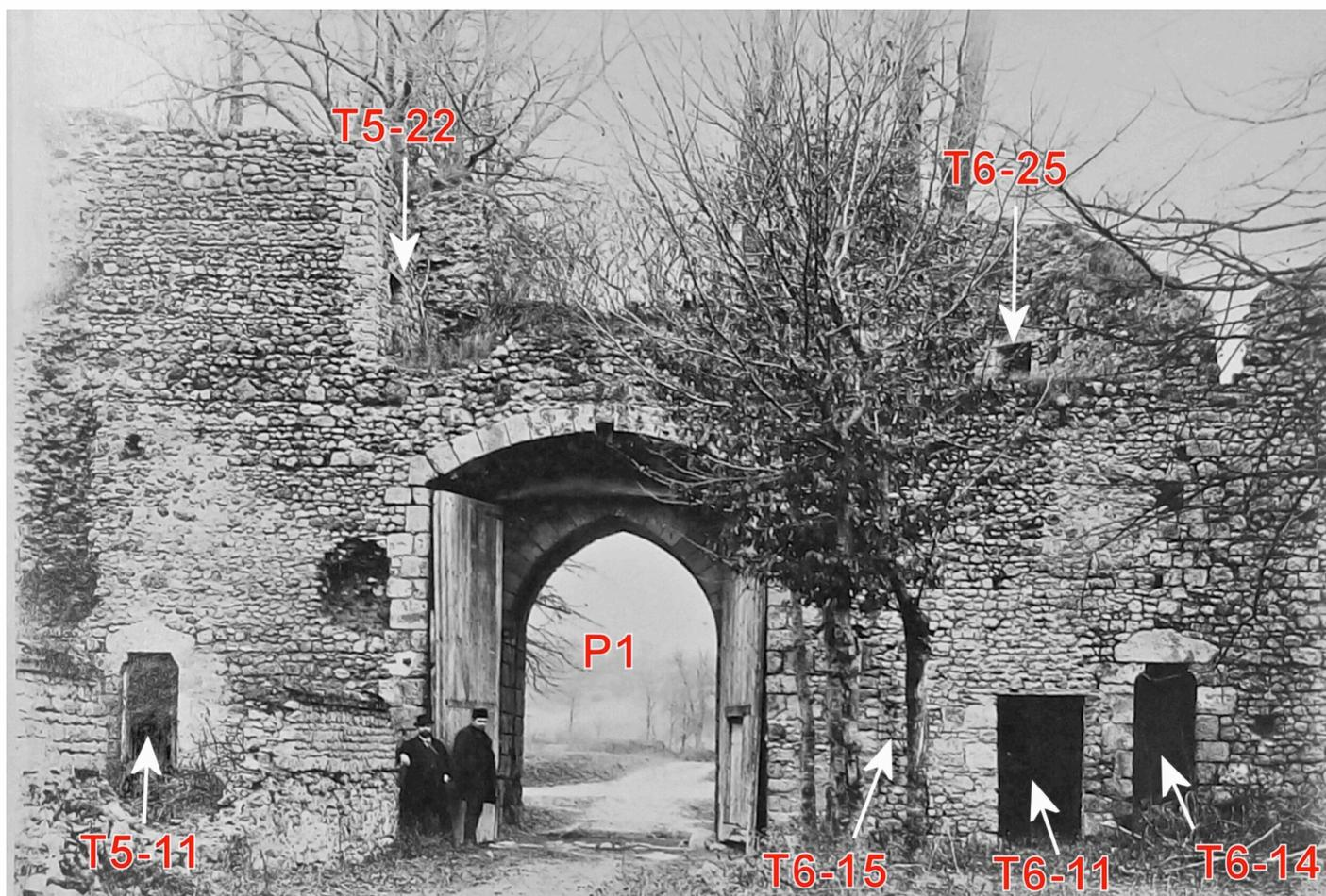
**Fig. F 32** - Photographie de 1884 (Bnf, cabinet des Estampes, EN1-41). L'arc segmentaire en mauvais état présente ses dispositions d'origine. Le niveau 2 de la tour T5 a été aménagé et couvert.
