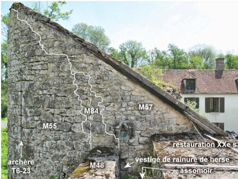
**Fig. F 26** - Tour T6 - Reprise de parement pour installation de la toiture. (Photo : Michel Piechaczyk / ADM).
